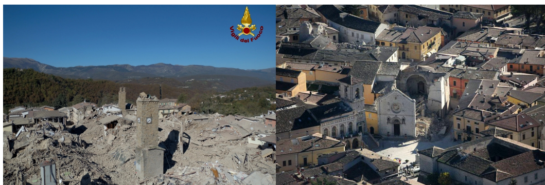
Fig. 1 - Foto aeree di Amatrice (a sinistra) e Norcia (a destra), riprese all'inizio di novembre del 2016.
