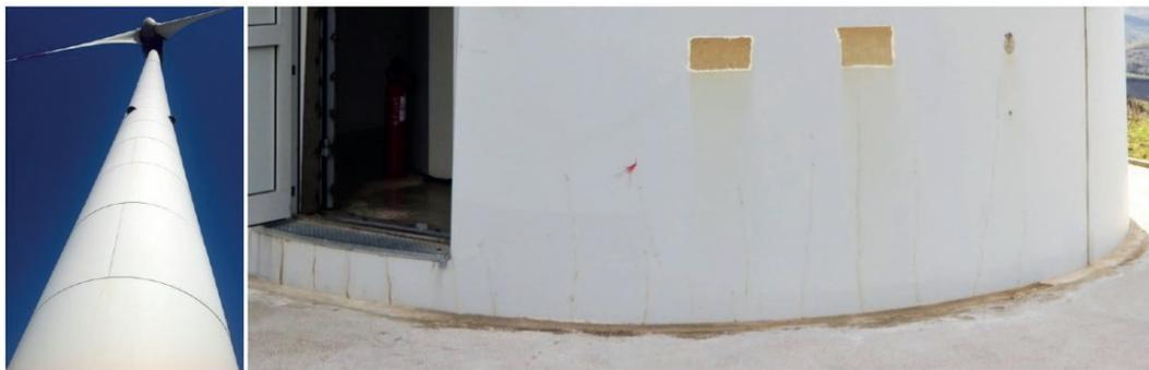
Fig. 1 - Immagini della torre e particolare delle lesioni verticali alla base del cono di terra.
