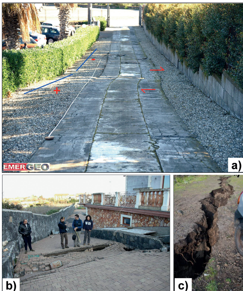
Fig. 3 - Esempio di tipologie di rotture cosismiche prodotte dal terremoto del 26 dicembre 2018 lungo la Faglia di Fiandaca: a) C.da Testa di Vipera; b) C.da Campanaro; c) Pennisi.
