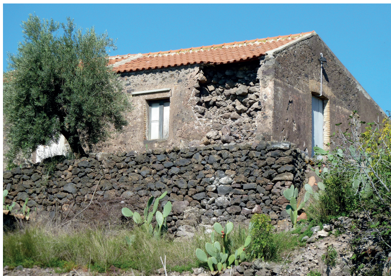
Fig. 2 - Svuotamento di un muro a sacco di un vecchio edificio in valle del Simeto.
